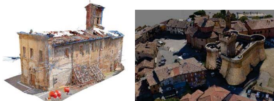
Figura 3. Rilievo effettuato con la tecnica del laser scanner 3d (sinistra) e rilievo effettuato con la tecnica della fotogrammetria (destra).
